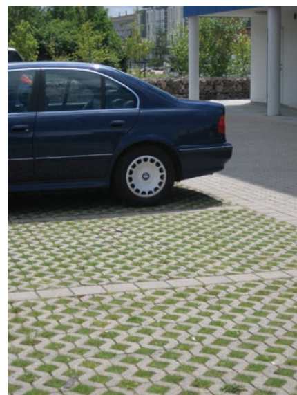
Figur 35: Permeabel græsarmering på parkeringsplads i boligområdet B001 i Malmø Västra Hamn. Græsarmering sikrer både nedsivning og fordampning af regnvand. Foto Orbicon
