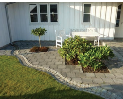
Figur 26: Regnvand ledes i en tæt rende bort fra huset til nedsivning i græsplænen. Foto Orbicon, Trekroner i Roskilde.
