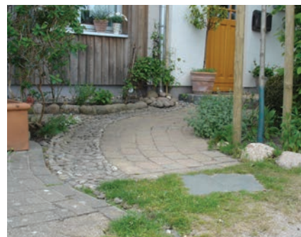
Figur 7: Afkoblet nedløbsrør ved rækkehusbebyggelse i Lübeck. Regnvandet ledes ud på græsplænen. Foto Orbicon.
