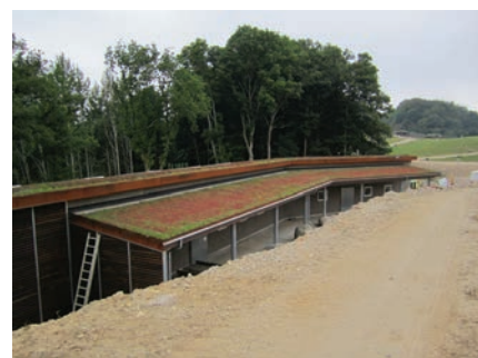
Figur 29: Sedumtag, Ree dyrepark. Foto Orbicon
