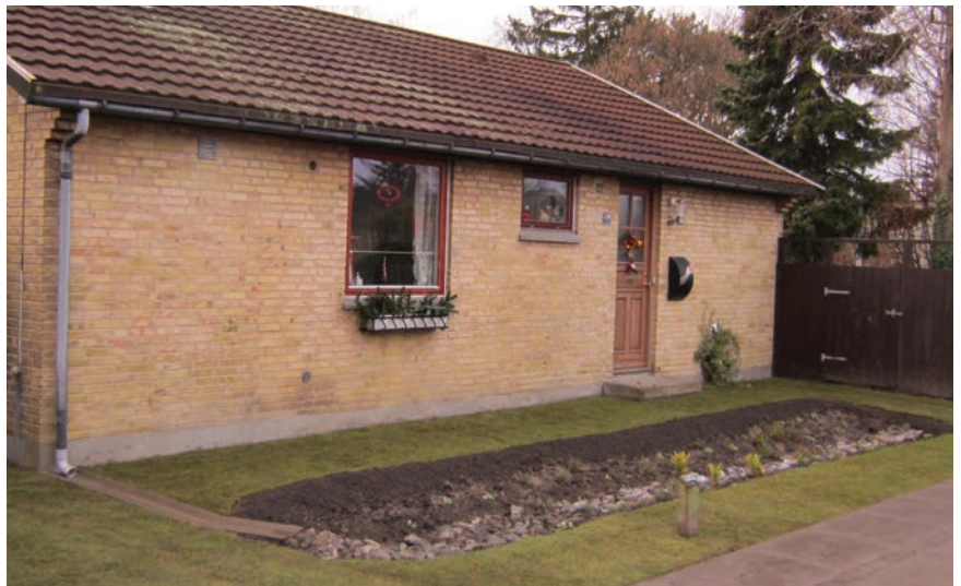
Figur 18: Nyetableret regnbed. Regnvandet ledes til regnbedet via en åben fliserende. Ved skybrud vil vandet løbe ud på vejen (bort fra huset). Brøndby Kommune har efter en vurdering af det konkrete projekt, lempet for de vejledende afstandskrav til bebyggelse og skel. Foto Spildevandscenter Avedøre.
