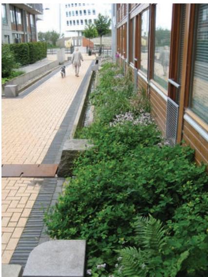
Figur 6: Beplantet regnbed, B001, Västra Hamn, Malmø. Foto Orbicon
