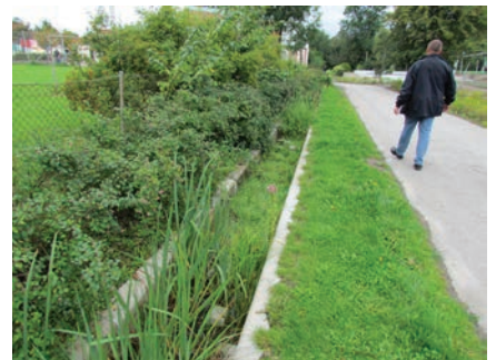
Figur 2: Rende til transport af regnvand. Augustenborg, Malmø. Foto Orbicon.
